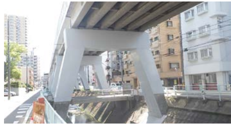
耐震補強を施した橋脚
