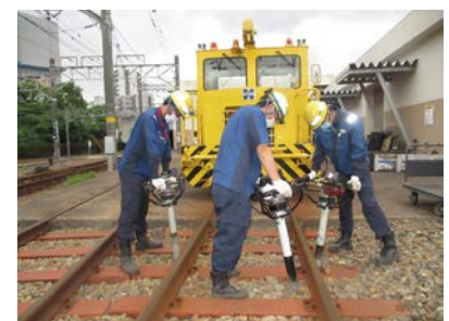
軌道保守(碎石道床つき固め作業)
