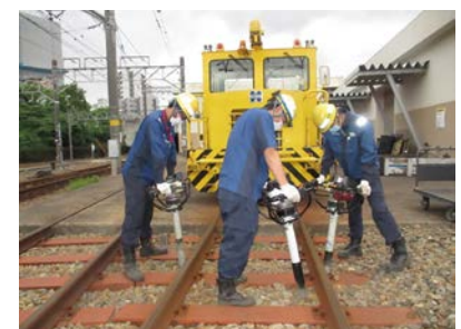
軌道保守(砕石道床つき固め作業)
