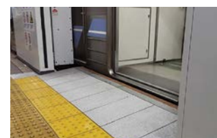
ホームと車両の段差・隙間の改善
