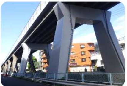
構造物の耐震補強
