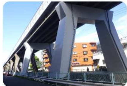
構造物の耐震補強
