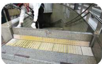
止水板立上げ訓練(水防訓練)
